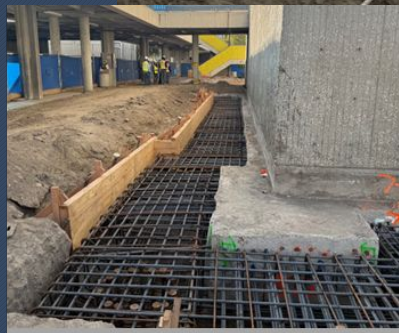
Rebar at Caissons Prior to Concrete Pour
