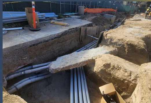
Electrical Conduit Placement
