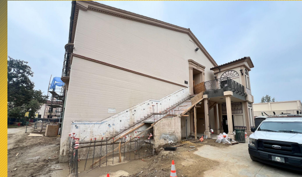
Pile Cap Concrete Pour
