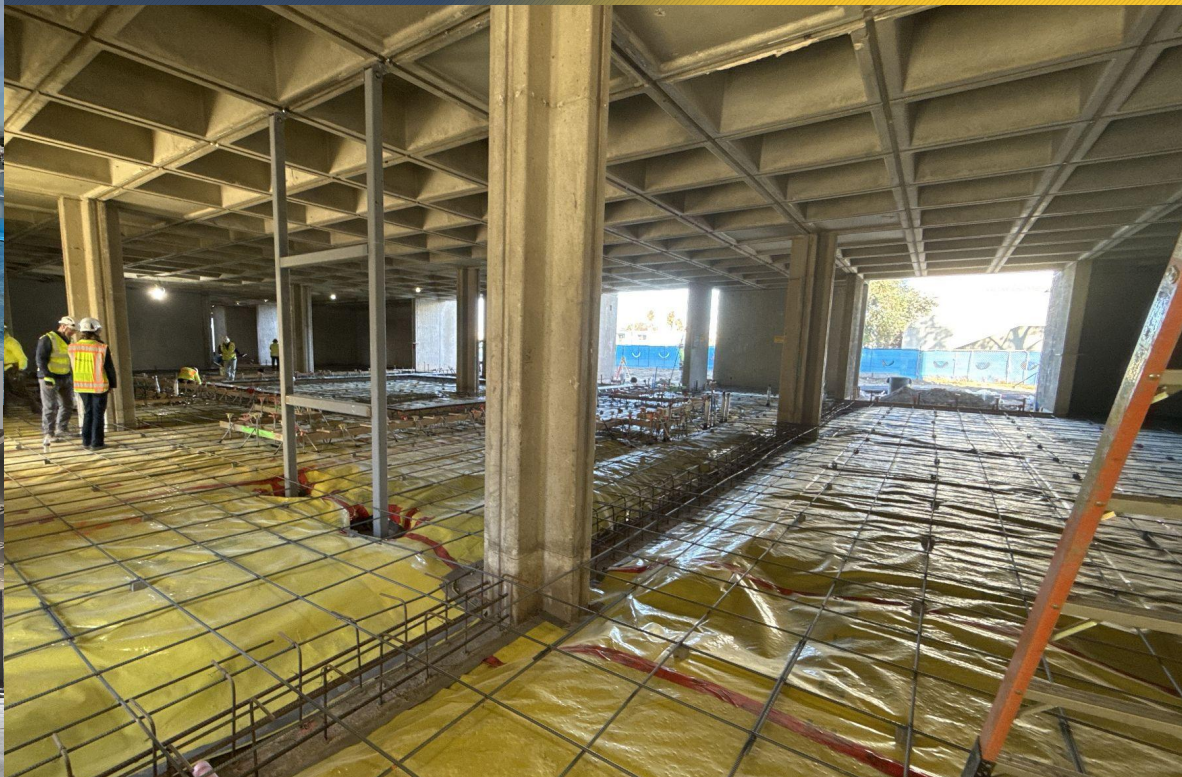
Slab on Grade Concrete Pour Preparation
